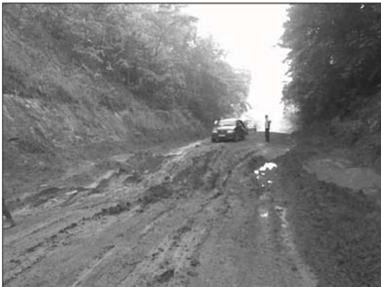
Foto 2 – Atoleiro na rodovia BR 156.
